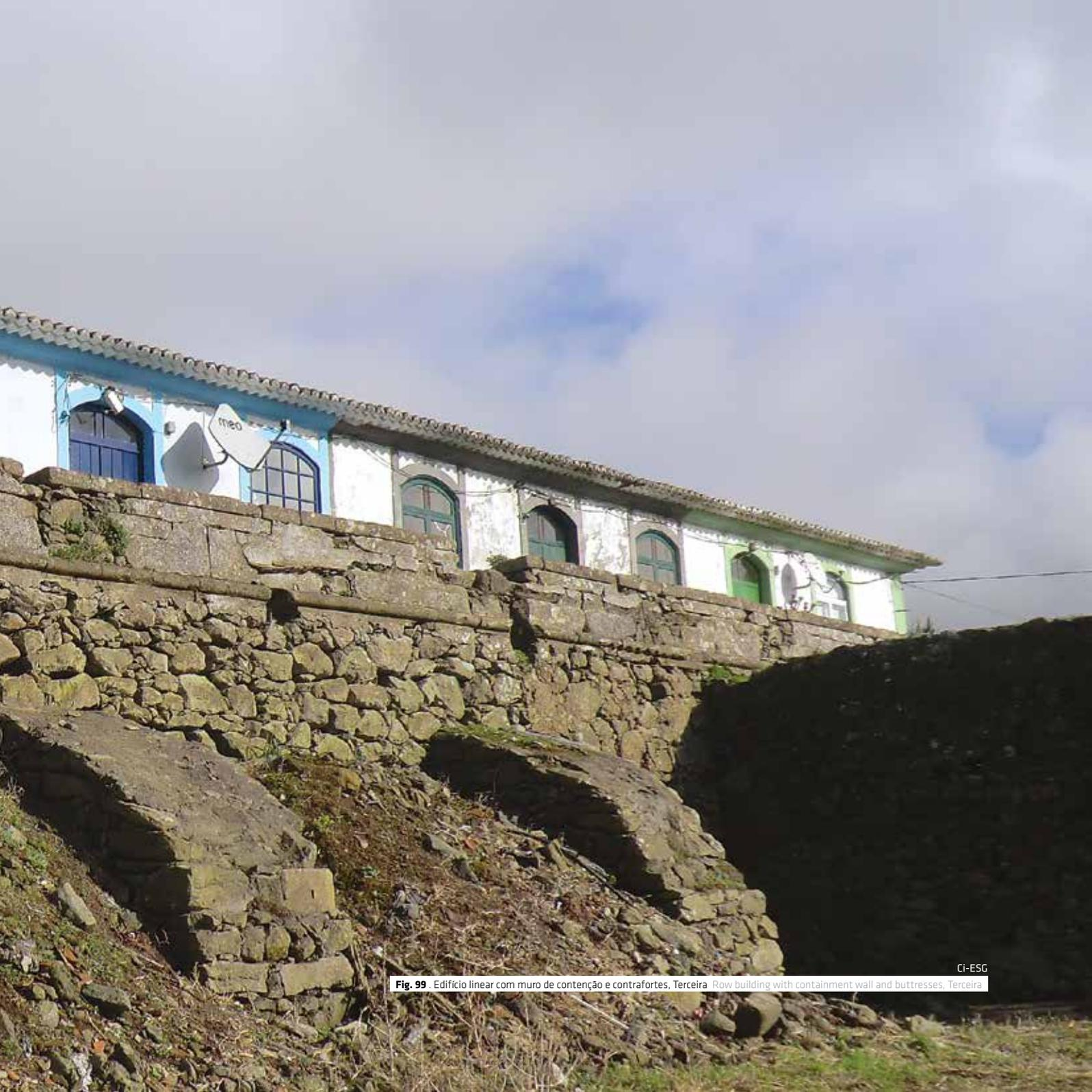
**Fig. 99** . Edifício linear com muro de contenção e contrafortes, Terceira Row building with containment wall and buttresses, Terceira
