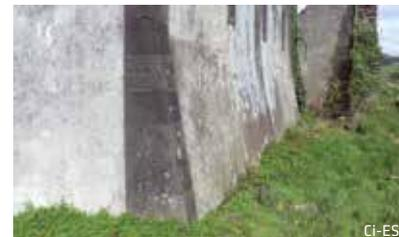
**Fig. 98.** Reforço de cunhal / Reinforced corner
