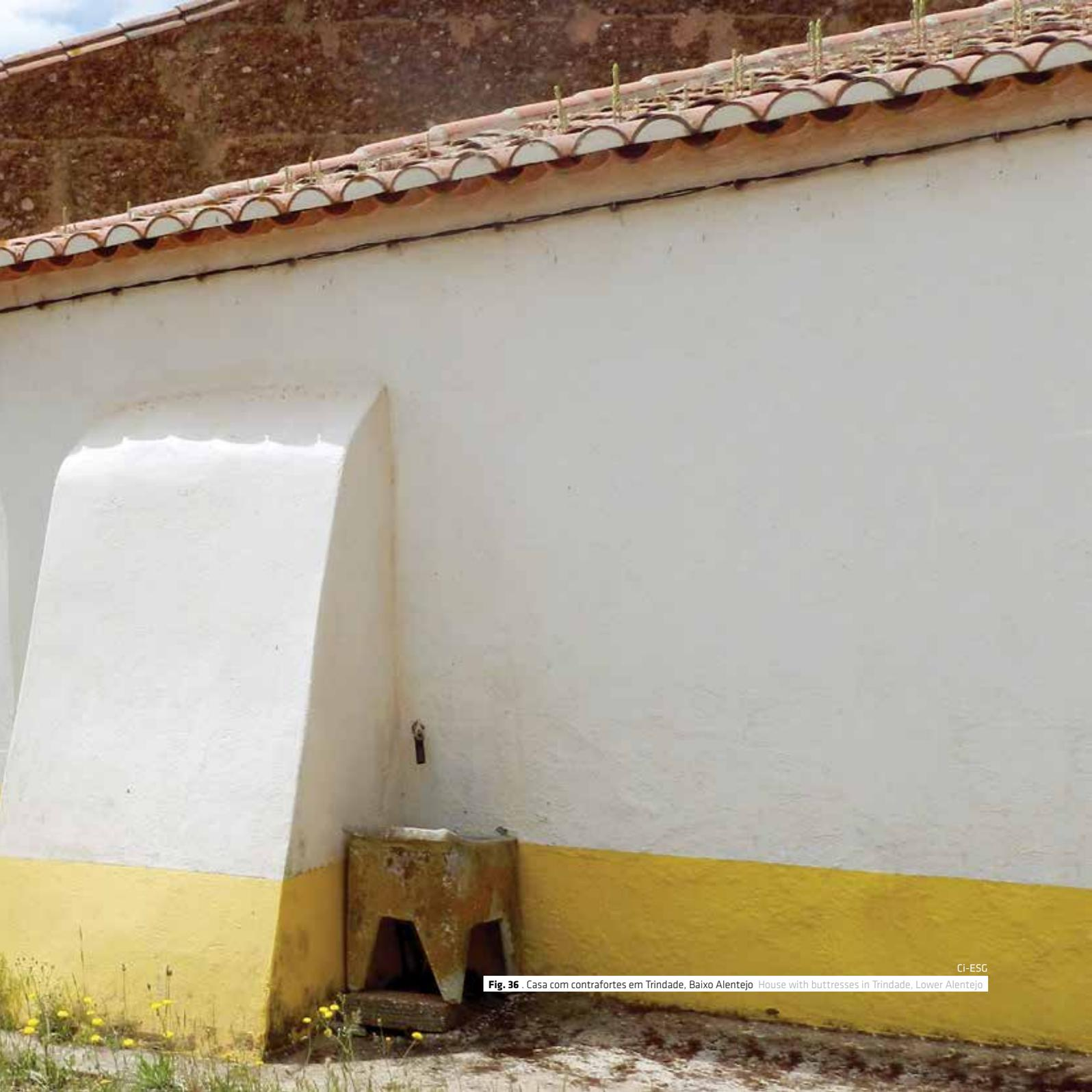
Fig. 36 . Casa com contrafortes em Trindade, Baixo Alentejo House with buttresses in Trindade, Lower Alentejo
