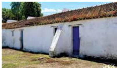
**Fig. 47** . Contraforte na fachada anterior Buttress on the back facade
