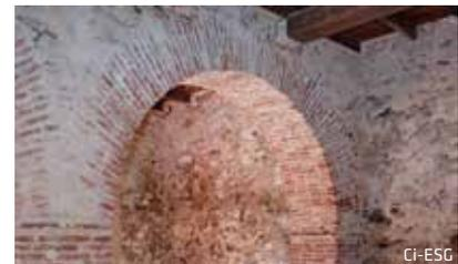
**Fig. 89** . Arcos de alvenaria de tijolo Arches of brick masonry
