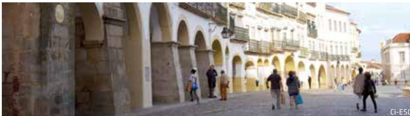
**Fig. 70** . Contrafortes de reforço das arcadas, Praça do Giraldo, Évora Buttresses reinforcing the arcades, Giraldo Square, Évora
